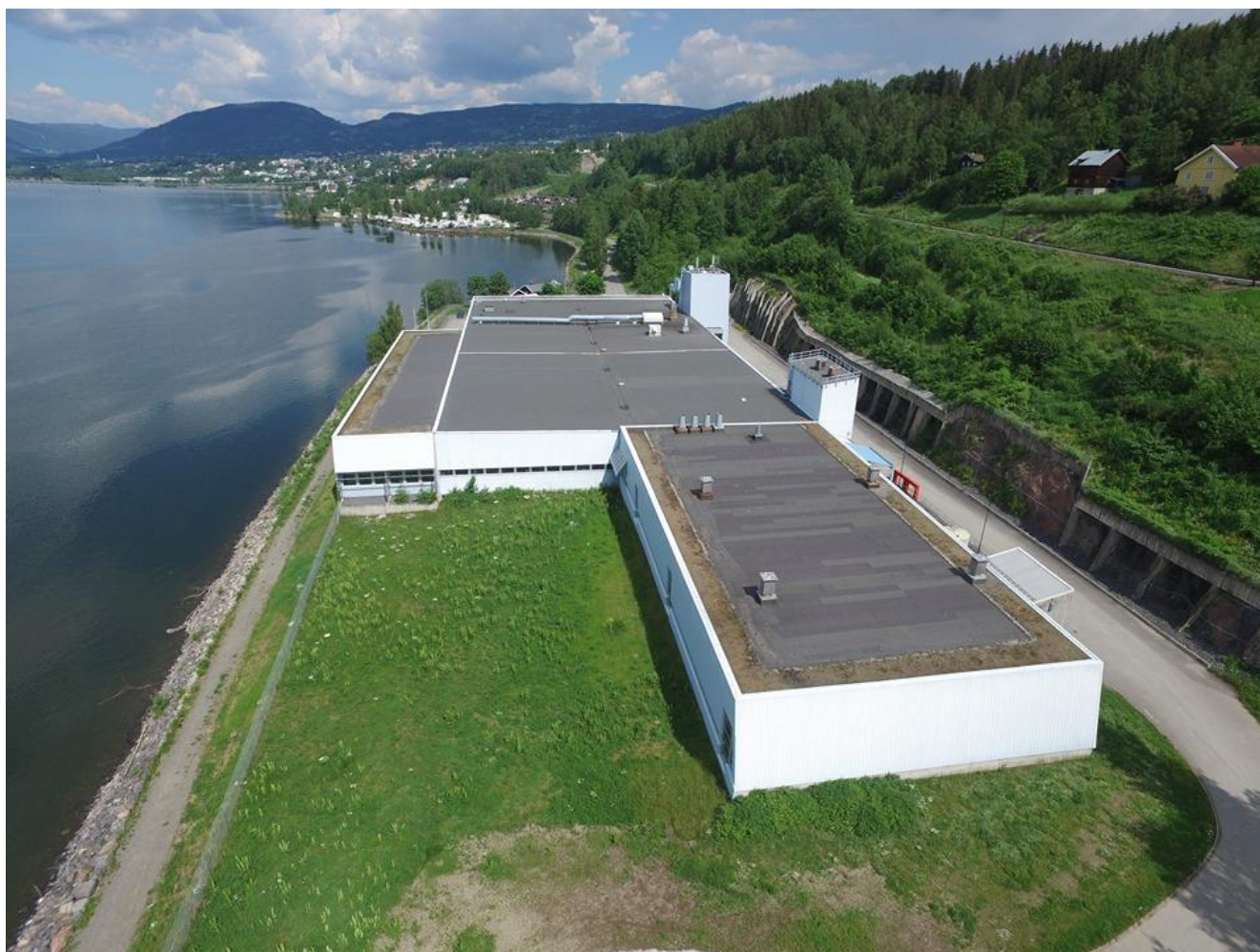
Figur 20 Lillehammer renseanlegg, i retning Lillehammer sentrum (foto: Rune Ludvigsen)
