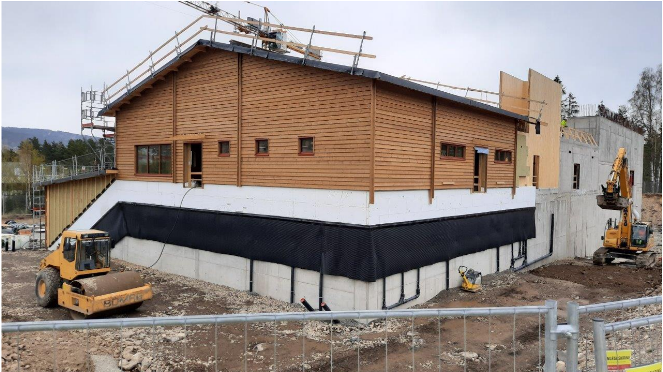
Figur 13 Lillehammer vannverk Hovemoen under bygging, våren 2020 (foto: Lars Philip Olausen)
