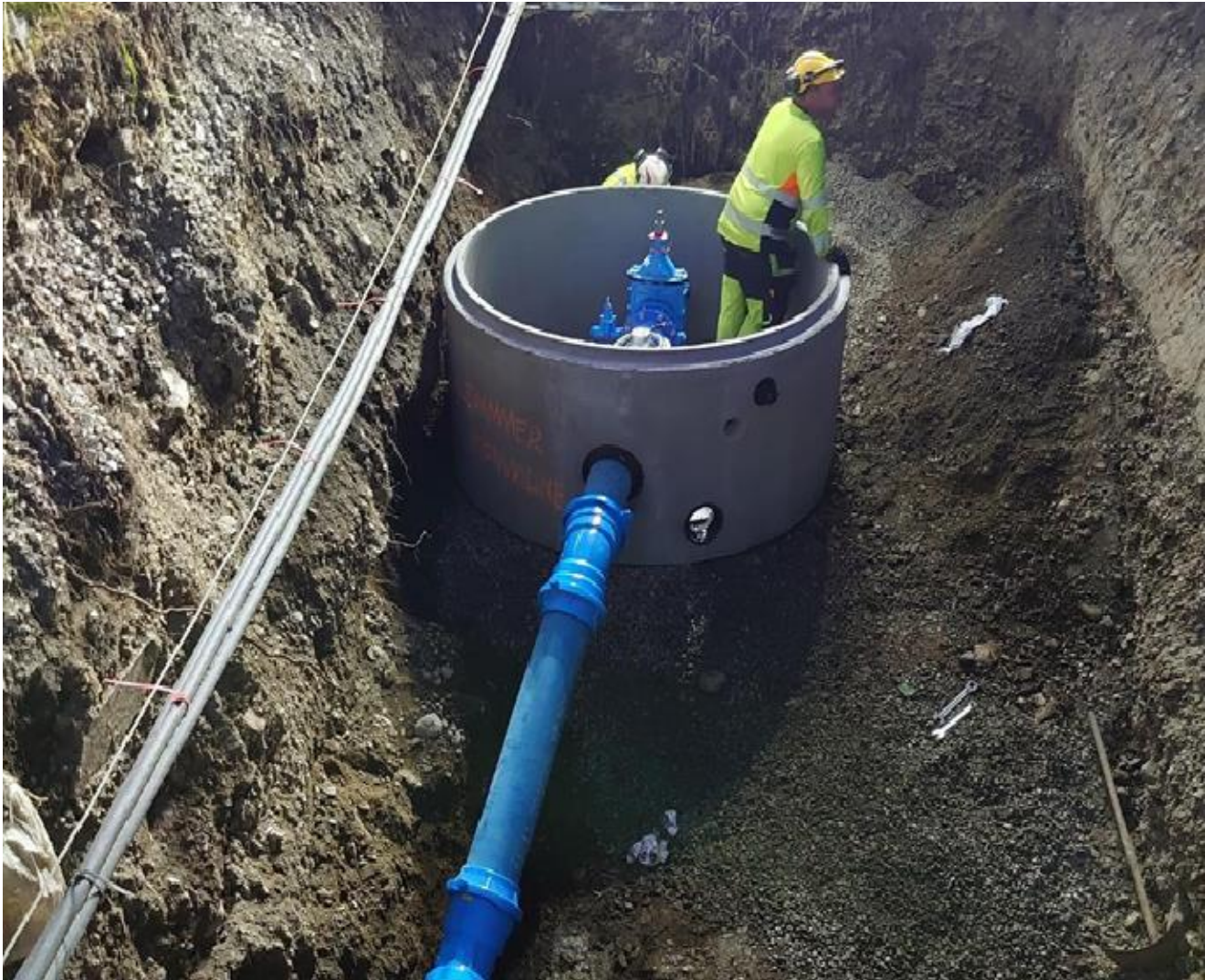
Figur 35 Servicelaget monterer første sonevannmåler i Vingnesvika sommeren 2020 (foto: Vidar Olsen).
