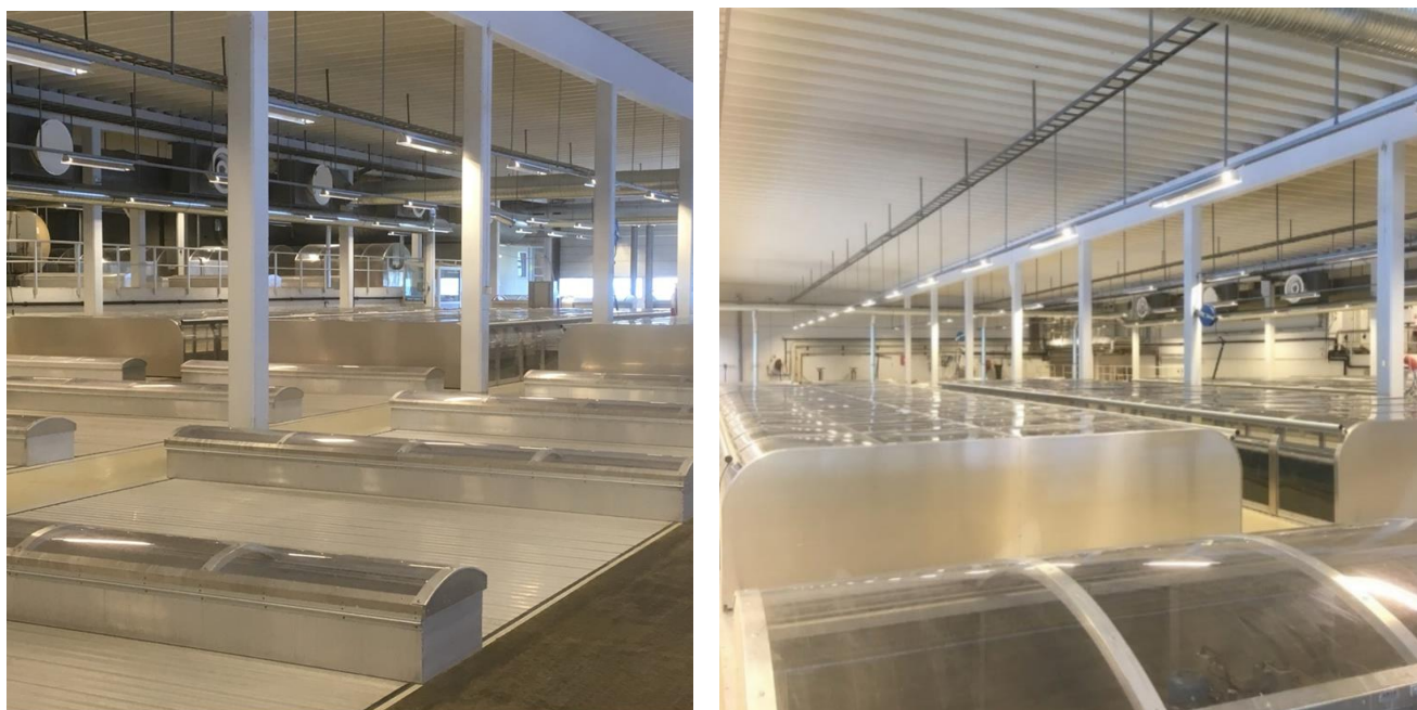
Figur 19 Renseanlegget etter at bassengene ble tildekket i 2004-2006 (foto: Stine Holmøy)
