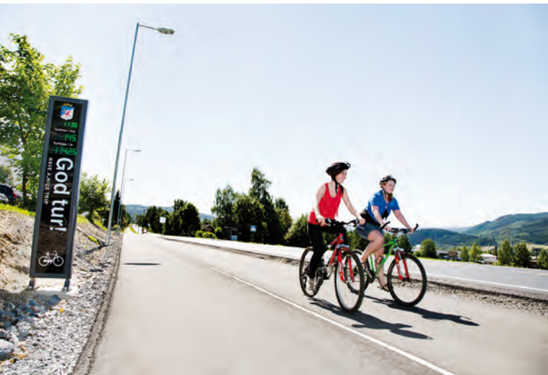
Eksempel på nyere høystandard tilrettelegging for sykkel og gange mellom Rosenlund og Storhove. Syklende og gående er separert fra hverandre – dette bidrar til å redusere konflikter mellom de to trafikantgruppene og bedre fremkommeligheten for sykklistene, foto: Kirsti Hovde
