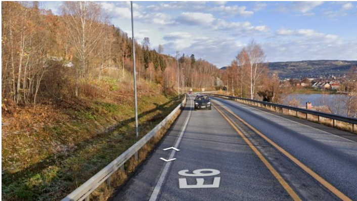
Figur 7 Dagens situasjon ved Riselandet (foto fra Google maps).
