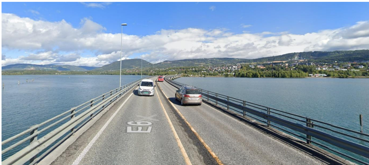
Figur 39 Eksisterende vegbelysning på Lillehammer bru er etablert med ensidig belysning på vestsiden av vegen med unntak av strekningen helt inn mot Strandtorget hvor belysning står på begge sider.
