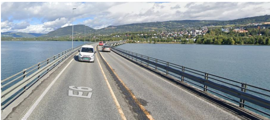
Figur 3 Dagens situasjon (foto fra google maps).
