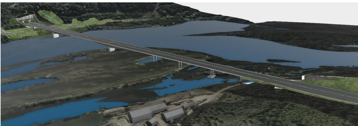
Figur 1-14. Lågen bru i justert linje, fritt frembygg-bru
