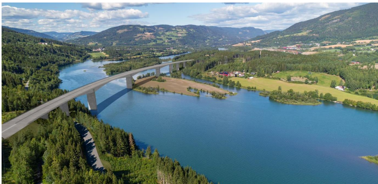
Figur 1-15. Lågen bru i kommunedelplanlinjen, fritt frembygg-bru
