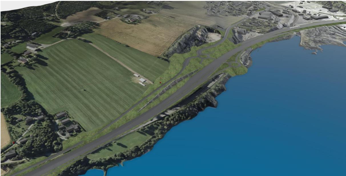
Figur 1-5. Vingrom kryss sør, ved Jevne
