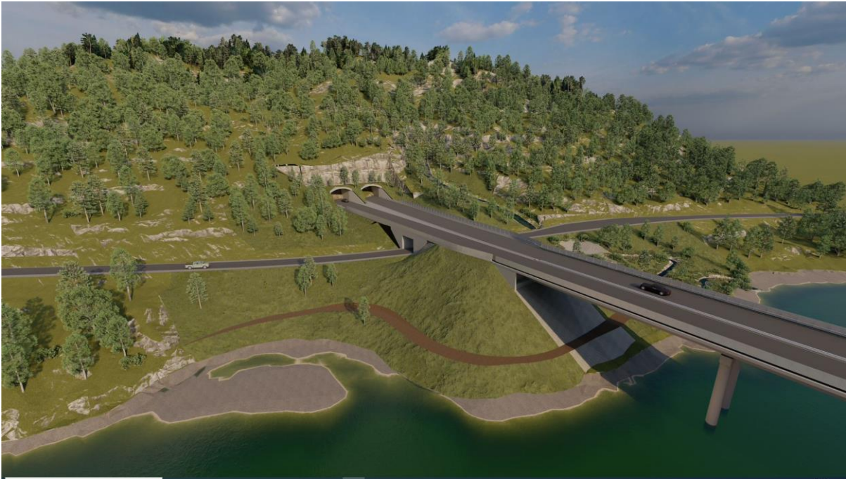
Figur 5-108 Illustrasjonen viser løsningen med kassebru, med portalområde og fylkesvei i kulvert under E6. Naturlig revegetering og beplantning vil dempe de visuelle virkningene. Kollefallbekken til høyre for portalen.
