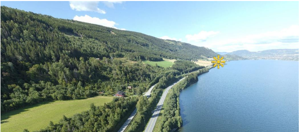
Figur 5-39 Bilde av deler av arealer for planlagt kryss nord, sett fra like nord for Ullhammeren. På strekningen fra Vingrom til Røyne er det sidebratt og skog langs stradsonen. (Dronebilde AF 2020)
