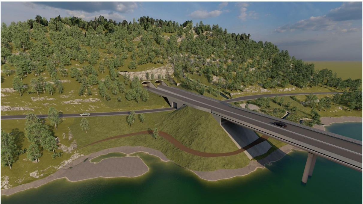
Figur 5-110 Illustrasjon som viser området der kassebrua treffer land på Trossetsiden. Fylkesveien legges om og går i kulvert under E6. Løsningen medfører behov for støttefylling, som går litt ut i Lågen.
