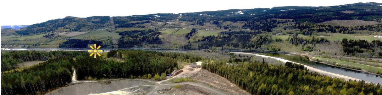
Figur 5-95 Bilde sett fra Storhove som viser skogklede arealer i vestre deler av Hovemoen. Deler av dette området vil endre karakter ved utbygging av næringsarealer. (Dronebilde AF 2020)
