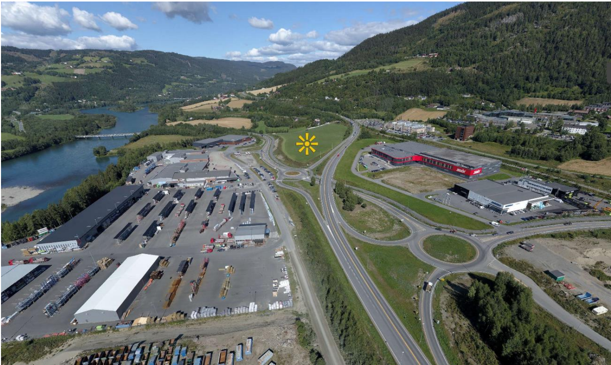
Figur 5-101 Bilde av veianlegg og næringsarealer sett fra sør. Område inneholder mange veier og rundkjøringer. Det reduserer lesbarheten av området. (Dronebilde AF 2020)
