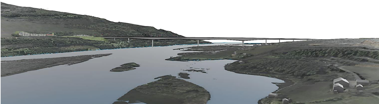
Figur 5-125 Bilde av brua fra modell fra Lillehammer. Høyde og linjeføring gir et tiltak som i stor grad bryter med landskapets karakter og skala.
