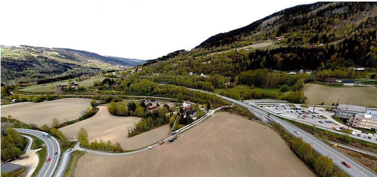
Figur 5-105 Bilde av området sett fra sør. Ny E6 er planlagt over jordbruksarealene i forkant av bildet. Jordet er regulert til næringsformål. (Dronebilde AF 2020).
