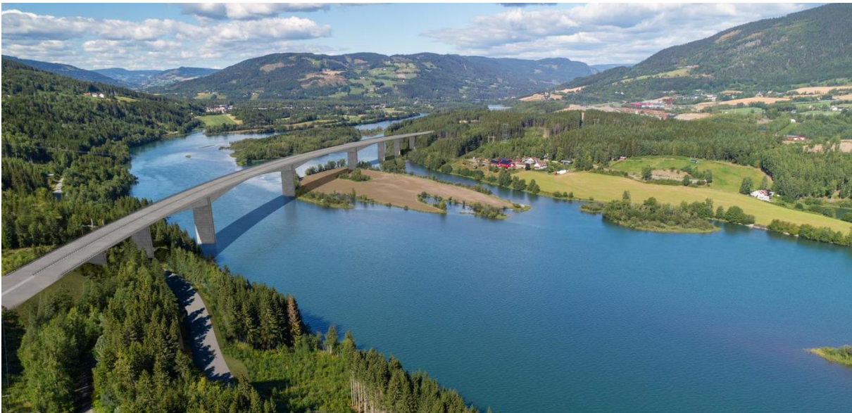
Figur 1-15. Lågen bru i kommunedelplanlinjen, fritt frembygg-bru
