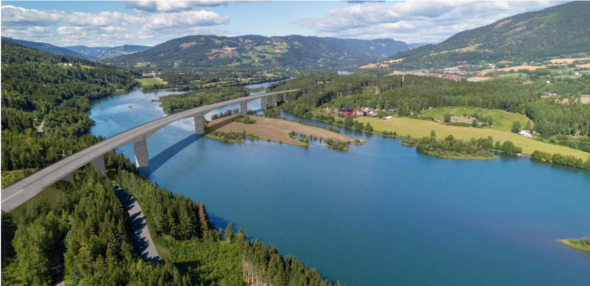
Figur 1-15. Lågen bru i kommunedelplanlinjen, fritt frembygg-bru
