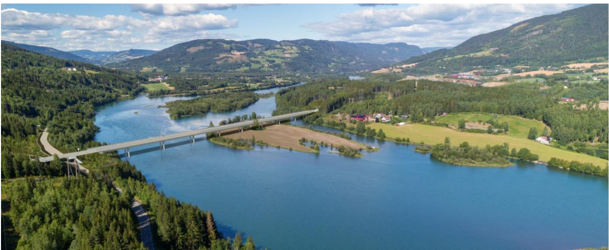
Figur 1-13. Lågen bru i justert linje, betongkassebru
