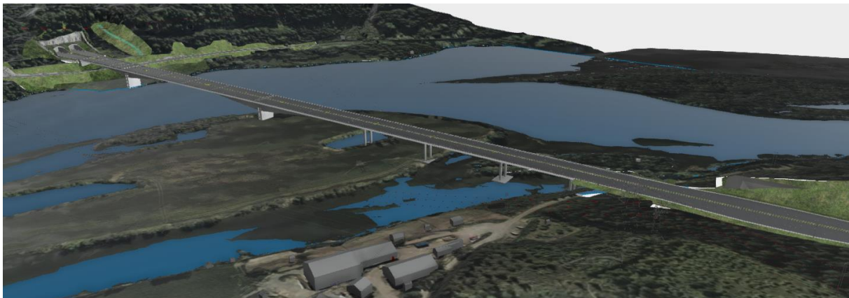
Figur 1-14. Lågen bru i justert linje, fritt frembygg-bru
