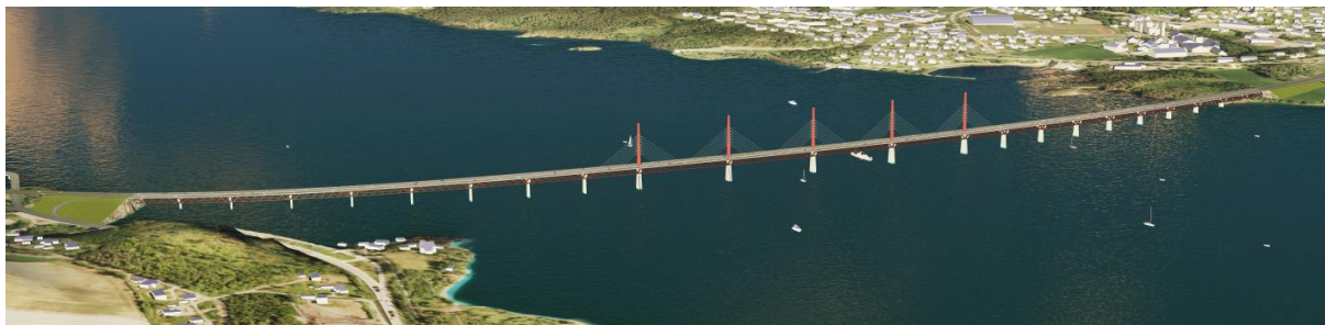
Figur 2-4 Oversiktsbilde av Mjøsbrua, sett fra sørvest /1/
