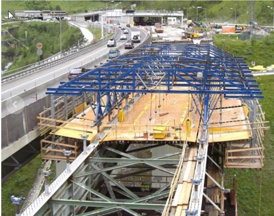
Figur 2-7 Prinsipp for overliggende flyttbar vogn. Bildet er hentet fra Doka sine nettsider.
