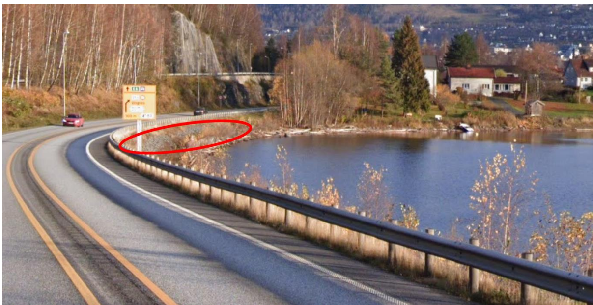
Figur 11: Utklipp fra Google Street View av Vingnesvika, sett mot nord. Rød ring markerer tydelige utbedringer av eksisterende vegfylling.
