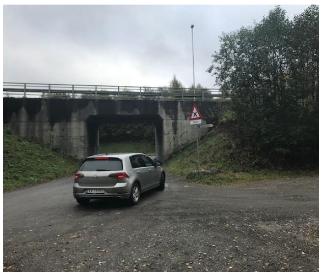
Foto av kulvert fra nedsiden (vest)
