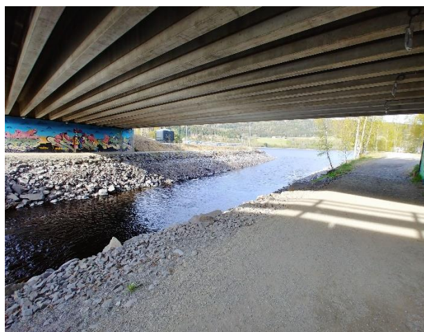
Bildet er tatt under E6-brua på nordsiden av Mesnaelva
