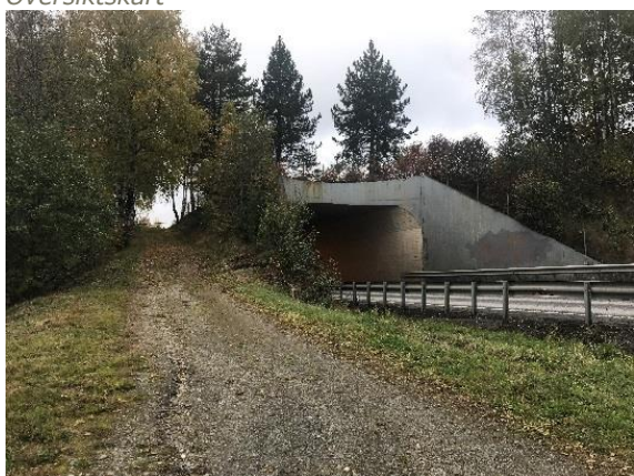
Foto av søndre sti langs kulvert
