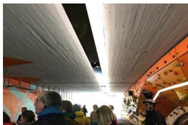
Eksempel på kulvert med lyst tak og belysning som gir visuell heving av takhøyde. (Groruddalen)
