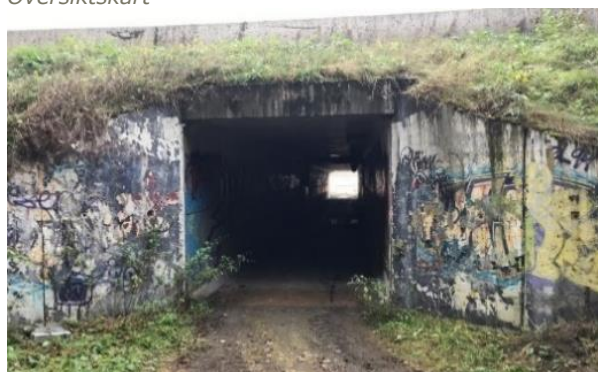
Adkomst til kulvert i nordøst, ved Bygghuset
