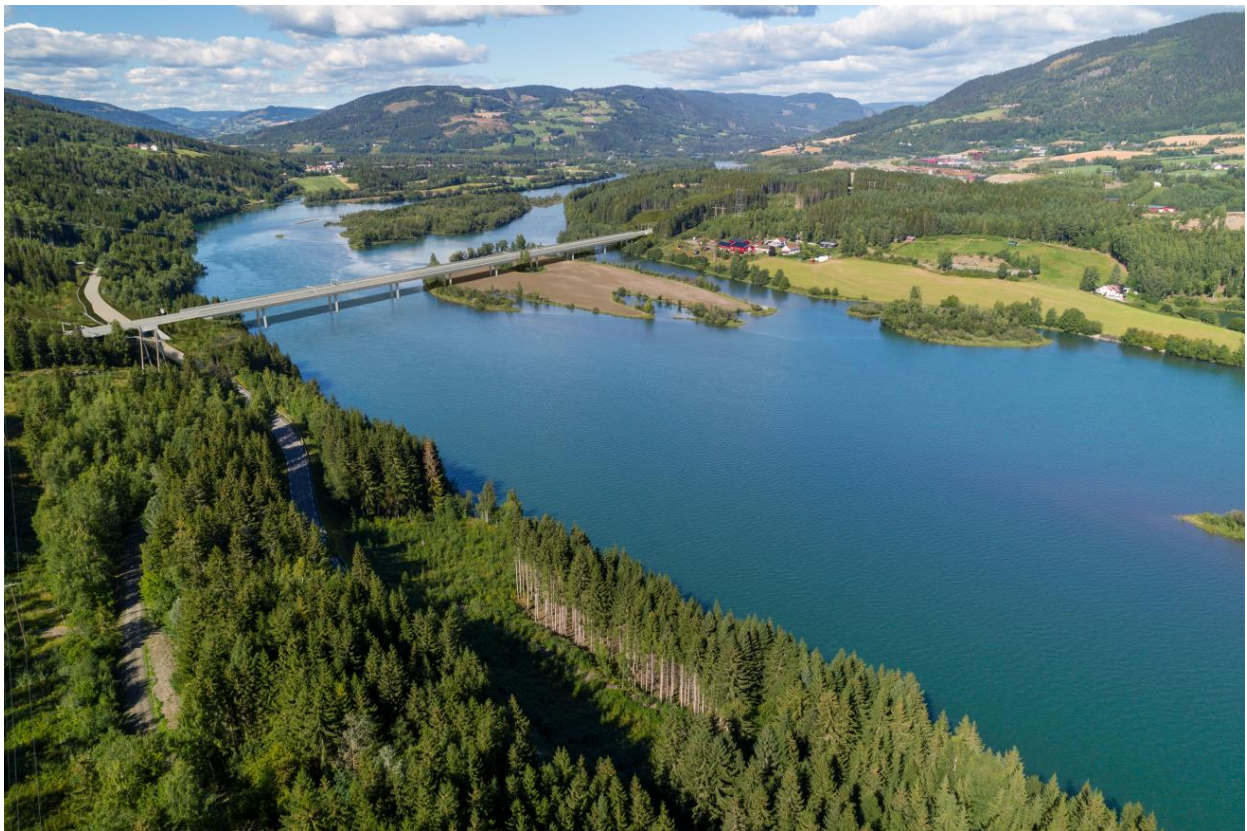
Figur 6-21. I planalternativ 1 reguleres en kassebru over Lågen. Brua er ca. 540 m lang, og veilinjen ligger ca. 15 m over høyeste regulerte vannstand.
