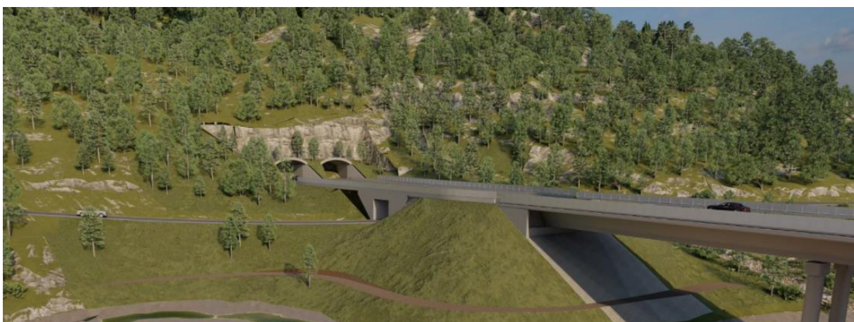
Figur 6-20. Portalområde på Trosset og overgang til bru over Lågen for planalternativ 1. Jørstadmovegen legges om og legges i kulvert under E6.
