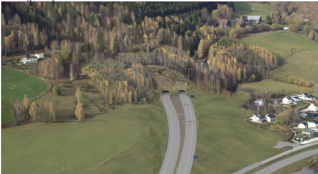
Figur 6-19. Forskjæring og portalområde Øyresvika.
