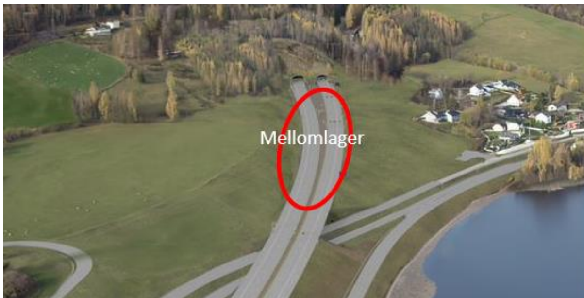
Figur 8-9. Midlertidig mellomlager i tilknytning til portalområdet ved Øyresvika.
