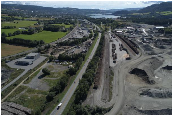
Figur 4-18. Dagens E6 ved Storhove ligger i midten av bildet. Dovrebanen ligger til venstre og Hove tømmerterminal og masseuttaket på Hovemoen ligger til høyre.
