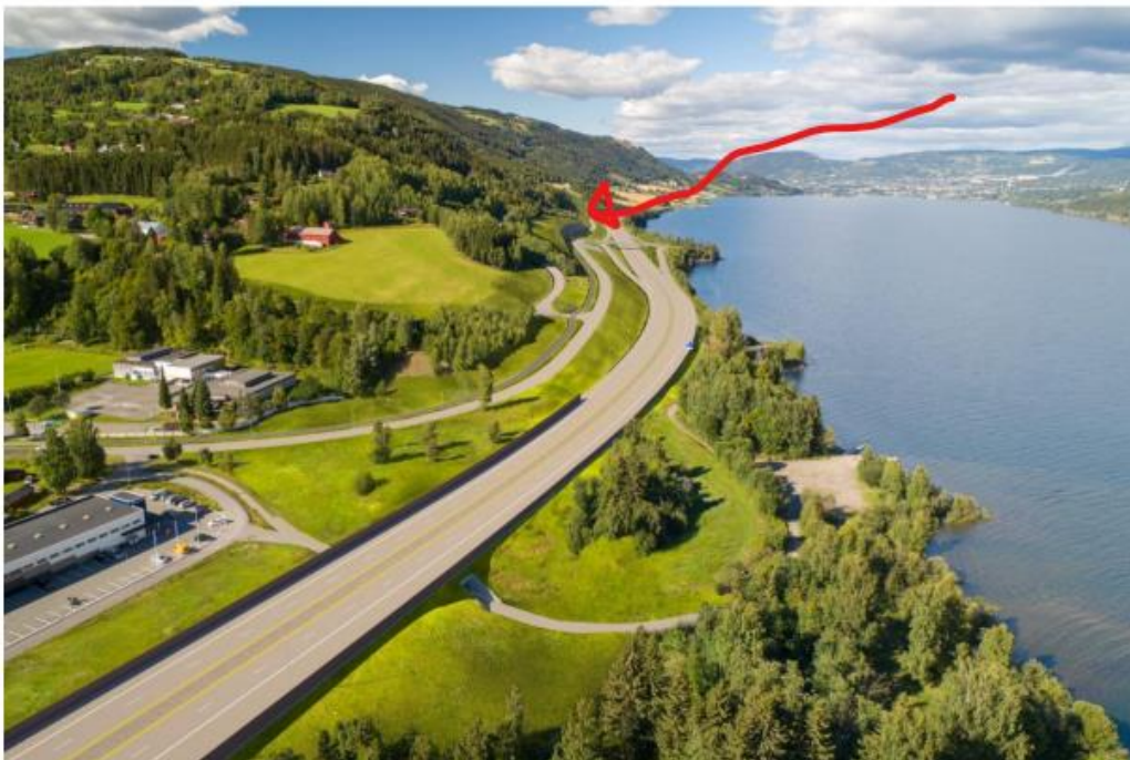
Figur 6-9. I planalternativ 1 reguleres Vingrom kryss nord ved Ullhammeren. Mot Vingrom sentrum er det regulert langsgående støyskjerm sør for kulvert og støyvoll nord for kulvert. Mot Vingromdammen reguleres langsgående støyskjerm.
