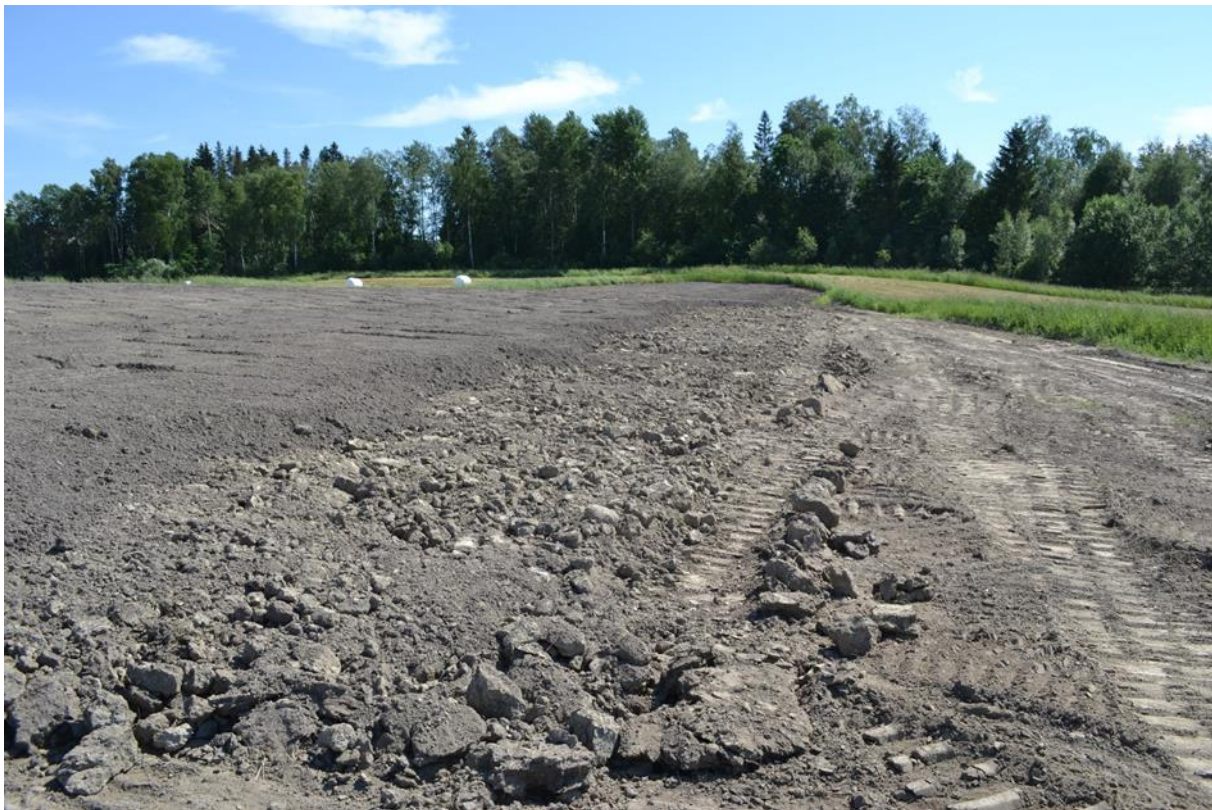
Figur 3-8. Jordløsning og reetablering av jordlag i opprinnelig lagrekkefølge på område for midlertidig masselager på NMBU, Ås (Foto: Trond Knapp Haraldsen)
