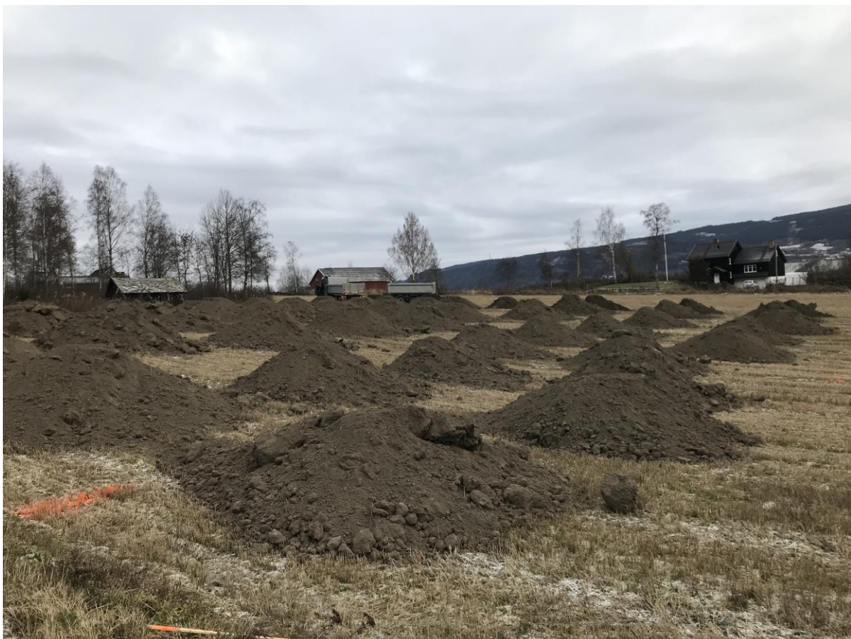
Figur 3-4. Flyttet topplag i hauger som ble jevnet ut med gravemaskin våren 2020 og sådd til ved normal våronntid (Foto: Erik A. Dahl).
