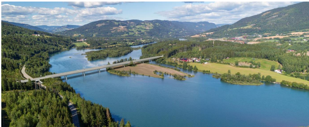
Figur 2-13. Lågen bru i justert linje, betongkassebru
