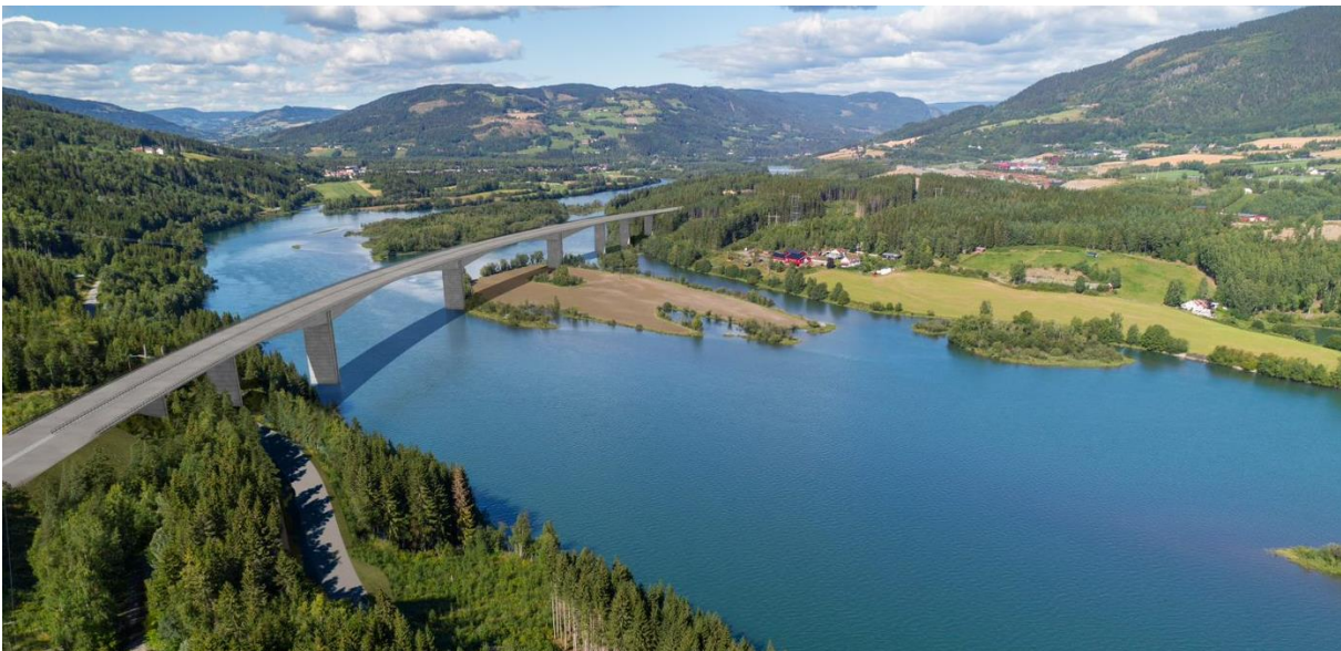
Figur 2-15. Lågen bru i kommunedelplanlinjen, fritt frembygg-bru
