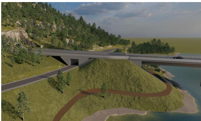
Figur 1: Ny kulvert på fv253 Jørstadmogevgen under ny E6
