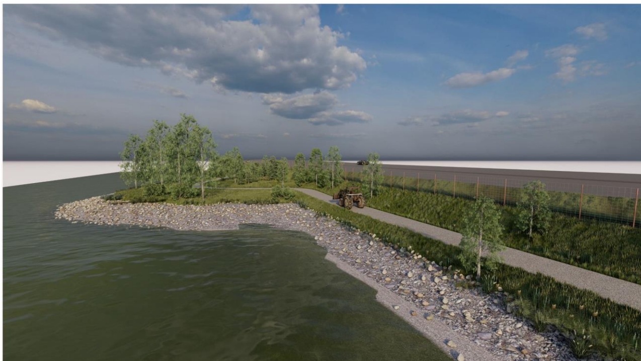
Figur 4. Turstien er en flerbrusløsning. Den etableres med ca. 3 m bredde i områder der den også skal fungere som driftsatkomst.
