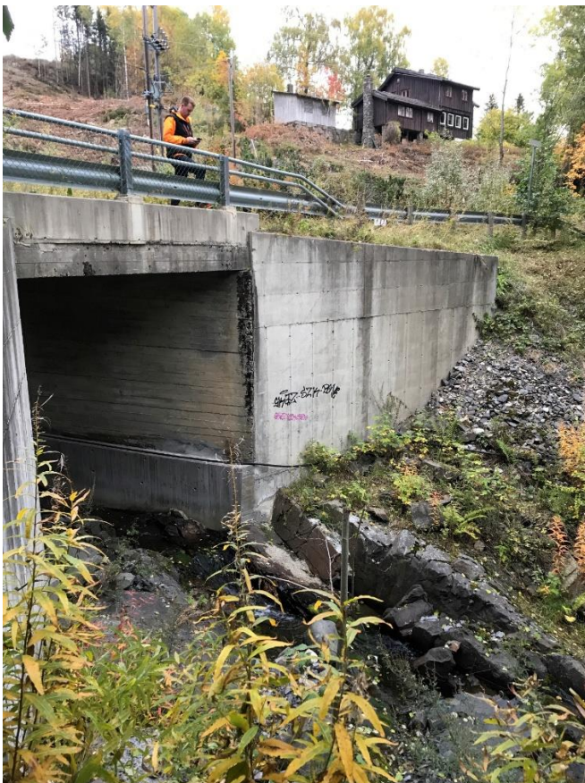
Figur 21 Ø5. I Øyresbekken er det observert berg i dagen, blokk og stein ved krysningen av Hovslivegen.
