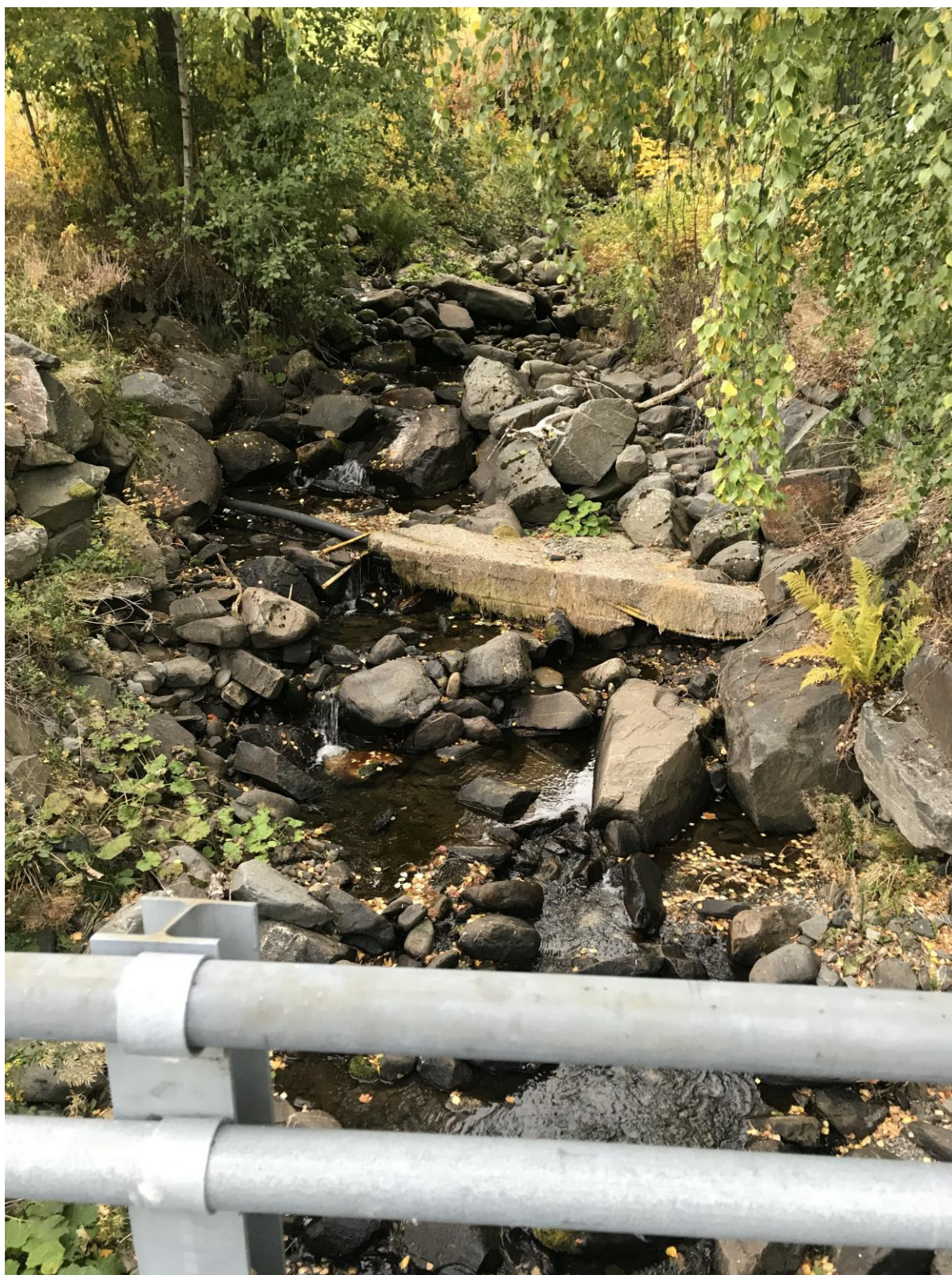
Figur 17 Blokk og stein i Øyresbekken ved krysningen av Vingromsvegen.
