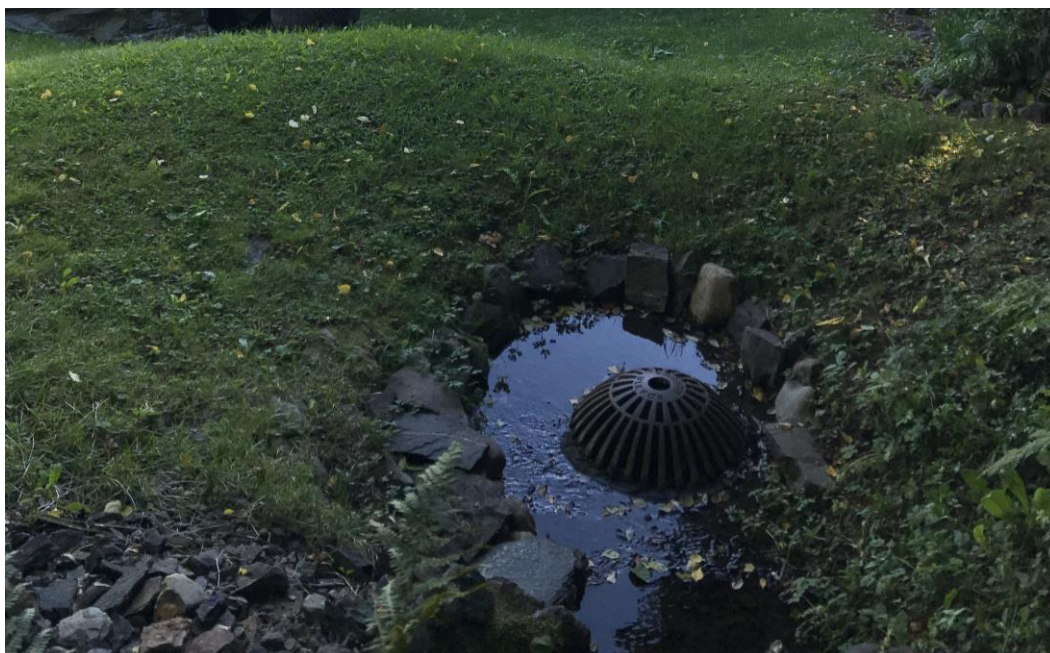
Figur 32 R2. Her er ble det observert en kum i overkanten av en eiendom hvor bekken føres ned.
