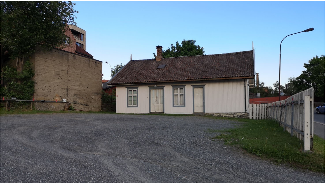
Bergs Hotell (Nordsetervegen 8) sett fra nordvest
