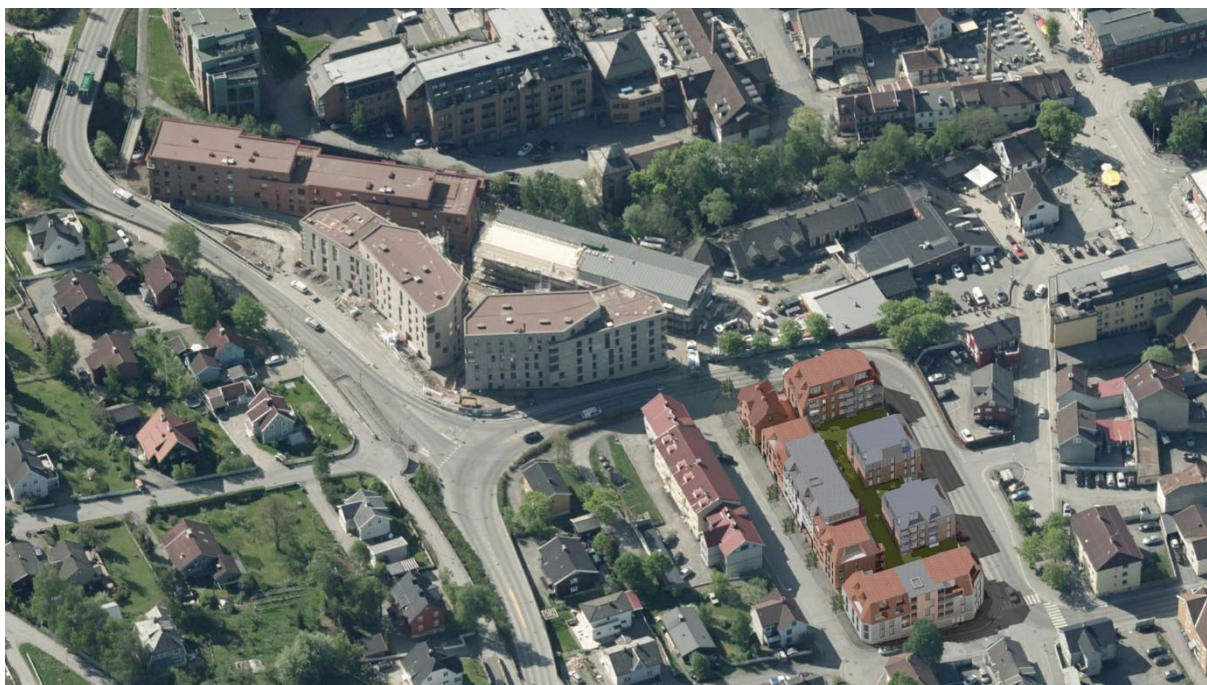
Kvartal 10B sett fra Gamlevegen
