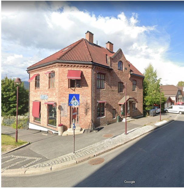
Ramsøy-bygget, Lars Skrefsrudsgate 2 Hjørne gård i tegl
