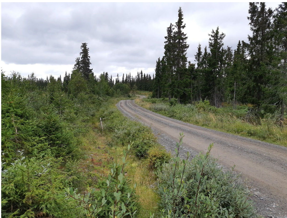
Foto som viser Sjogvegen og eksisterende grøft
