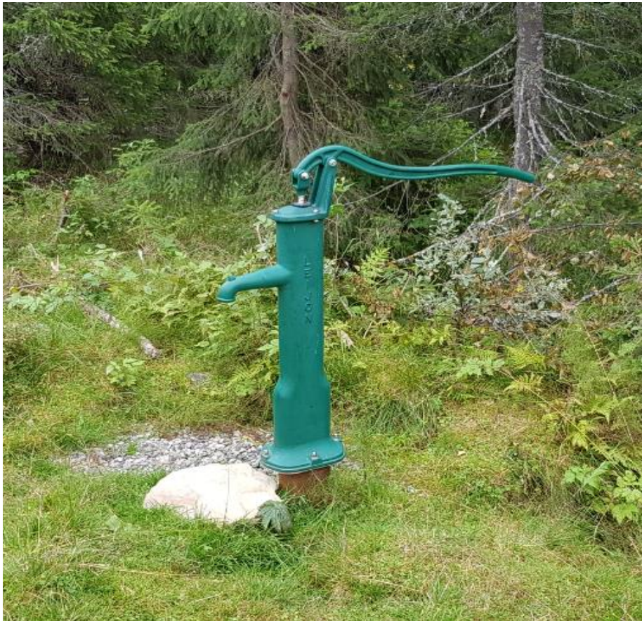
Figur 6: Eksempel på eksisterende felles vannpost basert på borebrønn i fjell og håndpumpe
