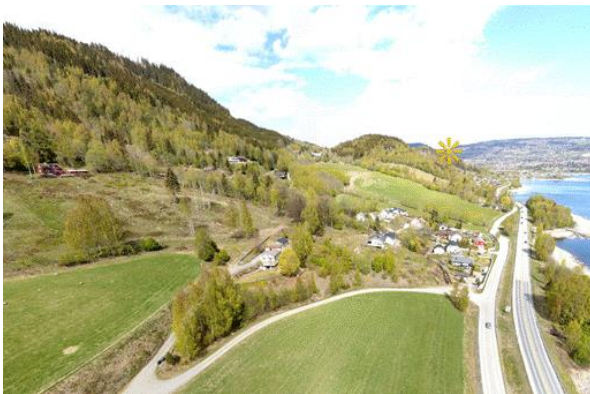
Figur 4-12. Tunnelen starter ved Øyresvika.
