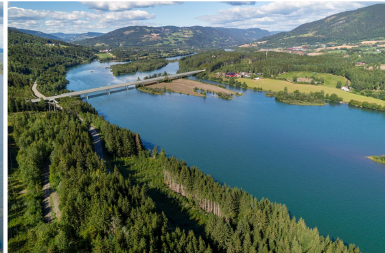
Justert linje med betongkassebru over Lågen
