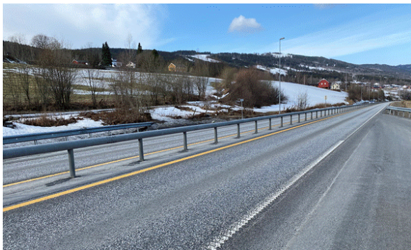
Figur 4-2. Store deler av strekningene er adskilt med midtrekkverk. (Foto: Norconsult AS)
