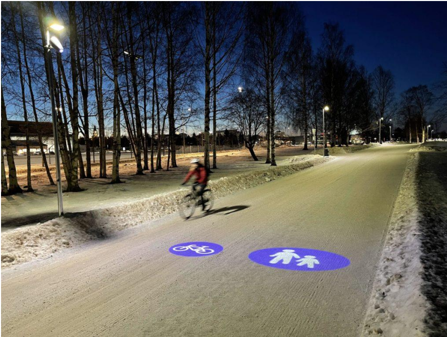
Kombinert gang- og sykkelveg. Bruk av lys projeksjon på snø. Oulu, Finland
