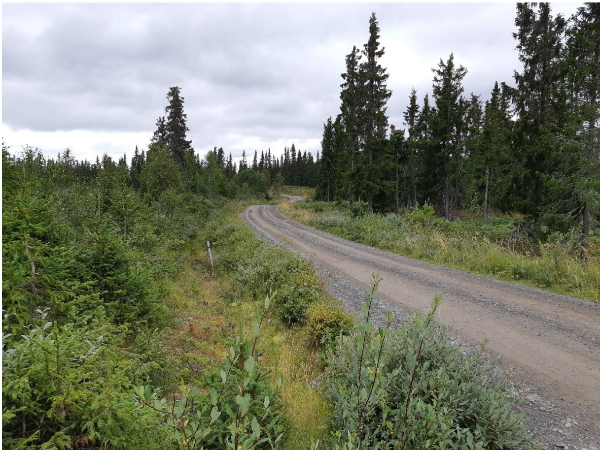
Foto som viser Sjogvegen og eksisterende grøft
