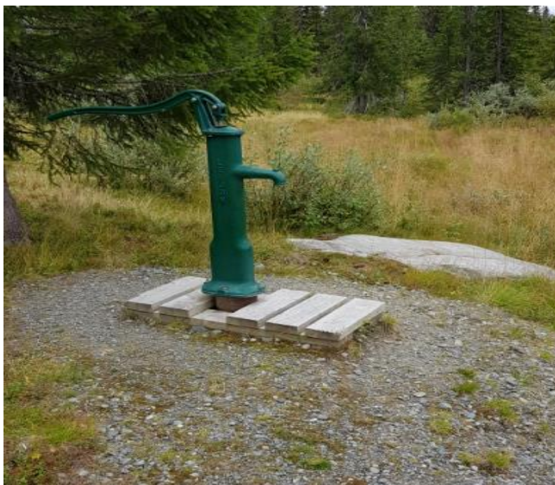
Figur 7: Eksempel på eksisterende felles vannpost basert på borebrønn i fjell og håndpumpe
