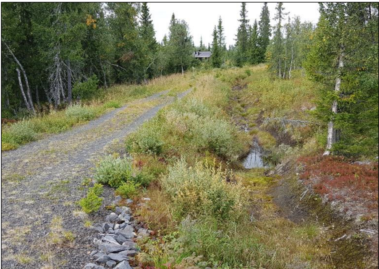
Figur 9: Etablerte grøfter langs veg
