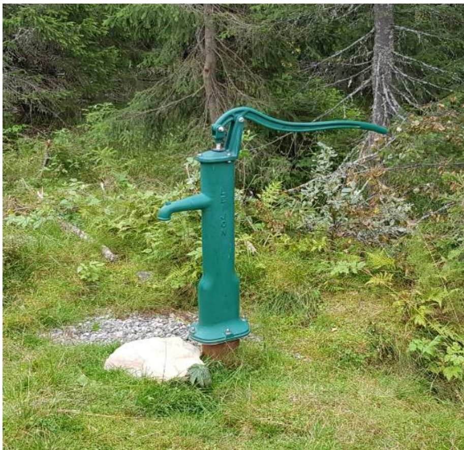
Figur 6: Eksempel på eksisterende felles vannpost basert på borebrønn i fjell og håndpumpe
